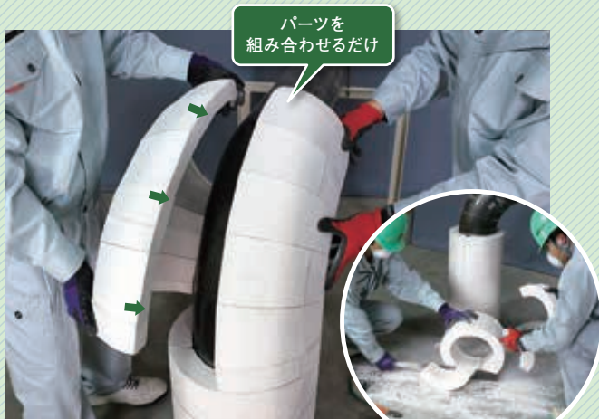
〈接着エルボ作業風景〉
